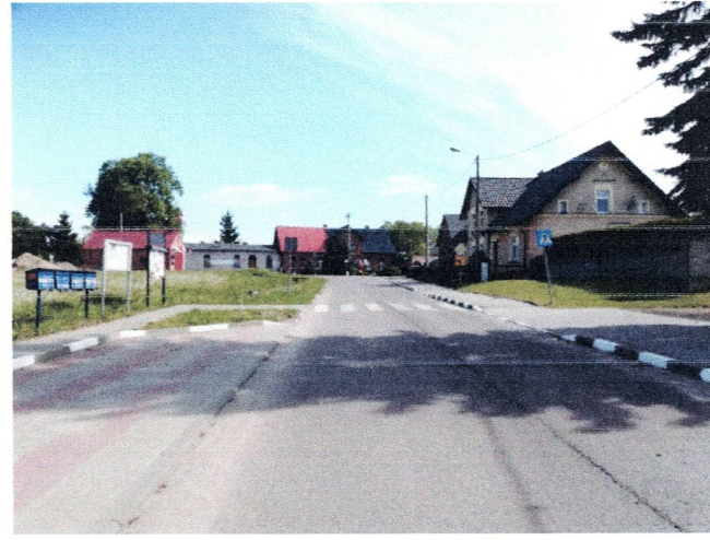
Droga przebiegająca przez centrum miejscowości
